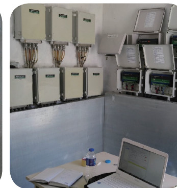
터키 DAM현장 설치사진
