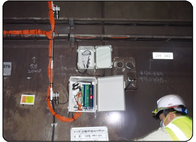
[ADL-16V 터널 설치 사진]
