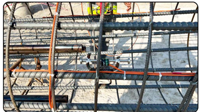
[파일 재하시험용 케이스에 1240 설치 사진]
